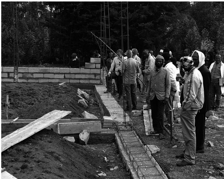
De nieuwbouw van de Sayimana School.
