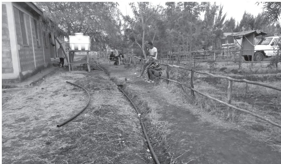
◆ Bij de Sebatamitschool wordt de waterleiding ingegraven.
